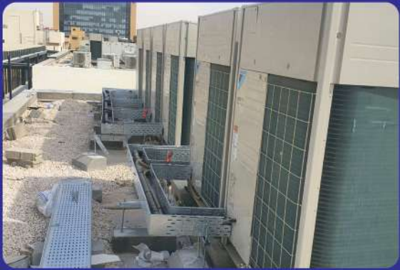
أعمال تكييف مركزي لكلية المجتمع - حريملاء الجهة المالكة : وزارة التعليم العالي
